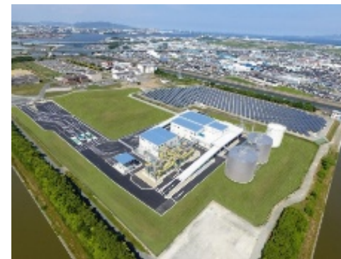
バイオマス発電施設
