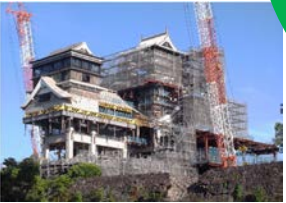
復旧中の熊本城
