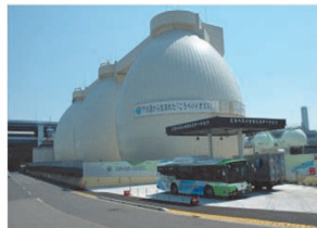
〈こうべバイオガスステーション〉
