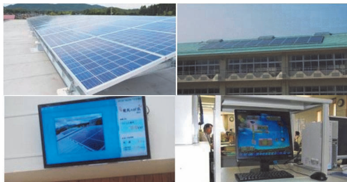
町内4小中学校に導入された太陽光発電システム
