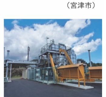
〈バイオメタノール製造及び発電施設〉
