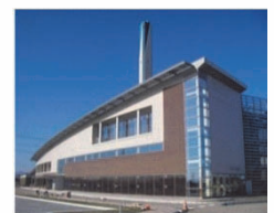
〈資源化センター 166.9kW〉
