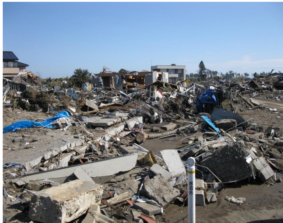
津波により壊滅状態の集落
