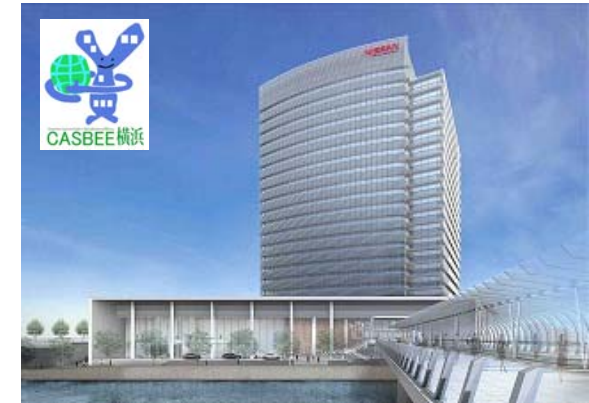
日産自動車(株)横浜本社イメージ （「CASBEE横浜」最上位ランク）
