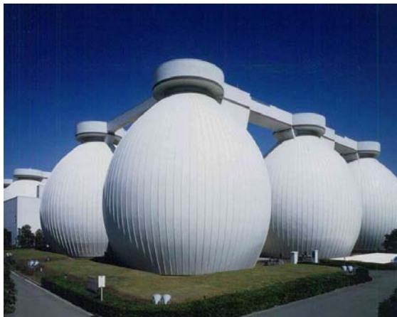
下水汚泥消化ガス発電(横浜市施設)
