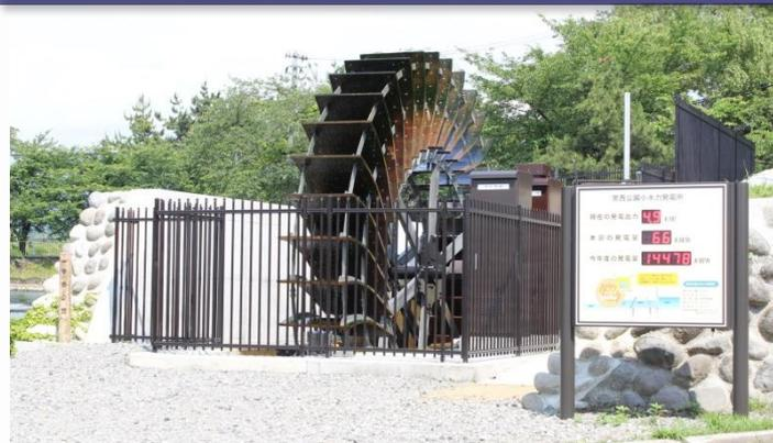
■発電出力:9.9kW ■年間発電量:84,300kWh
