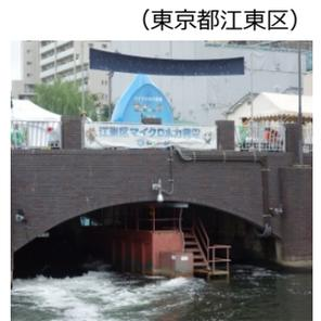
水力発電機と水滴の形をした表示モニター
