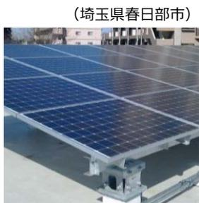
粕壁小学校屋上に設置した太陽光電池（防災対応型）
