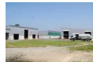
堆肥センター
