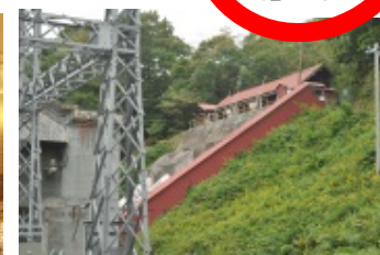
町内水力発電所
