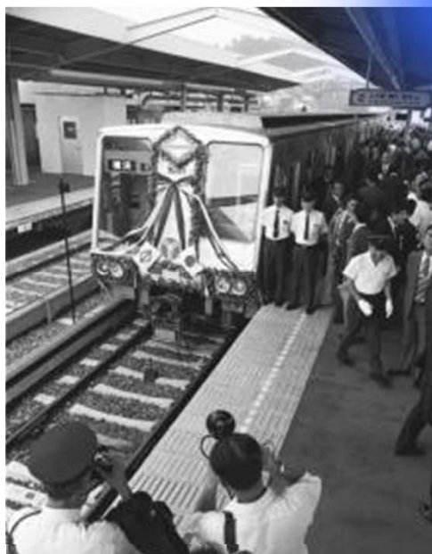
地下鉄建設事業
