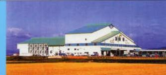
1500トンの雪により低温貯蔵を行う「米倉庫」(沼田)
