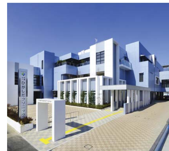
透析医療に蓄熱システムを取り入れた「ひがしだクリニック」
