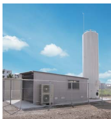
CEMSと連携して貯蔵した水素から電気と熱をつくるシステム
