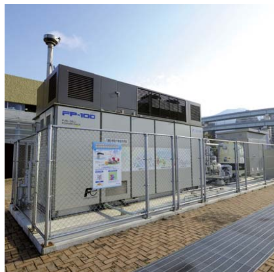
100kWの水素燃料電池
