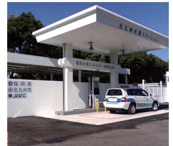
「北九州水素ステーション」
