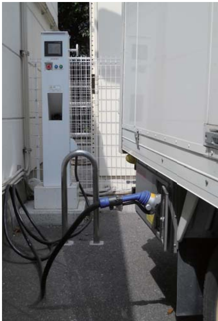
冷蔵・冷凍車のアイドルストップ中でも温度管理を可能にする「ファミリーマート」と「タカミヤ」設置の充電ポール
