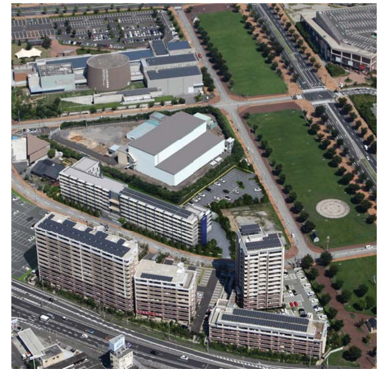
東田大通り沿いに並ぶ博物館・マンション屋根の太陽光発電群
