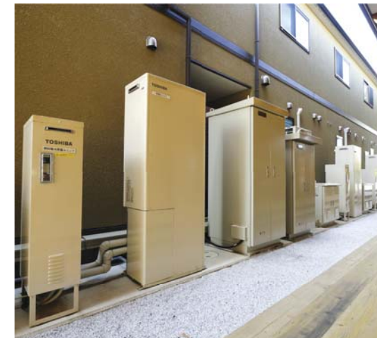
水素実証住宅「ひがしだH2」の燃料電池
