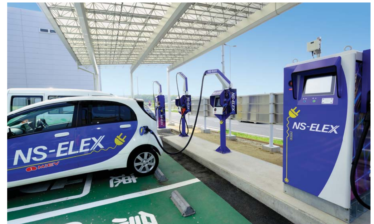
スケジュールや走行距離に応じて効率的な充電を行う「日鉄住金テックスエンジ」の急速EV充電器
