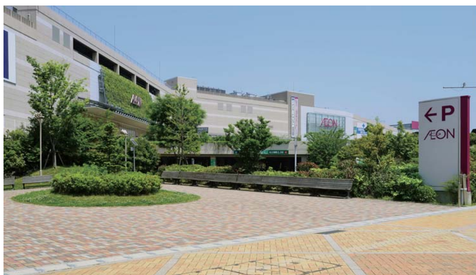
地域節電所と連携し館内の電力需要のピークカットを行う「イオンモール八幡東」
