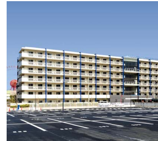
太陽熱・風・地中熱を利用した「新日鉄住金エンジニアリング」北九州寮
