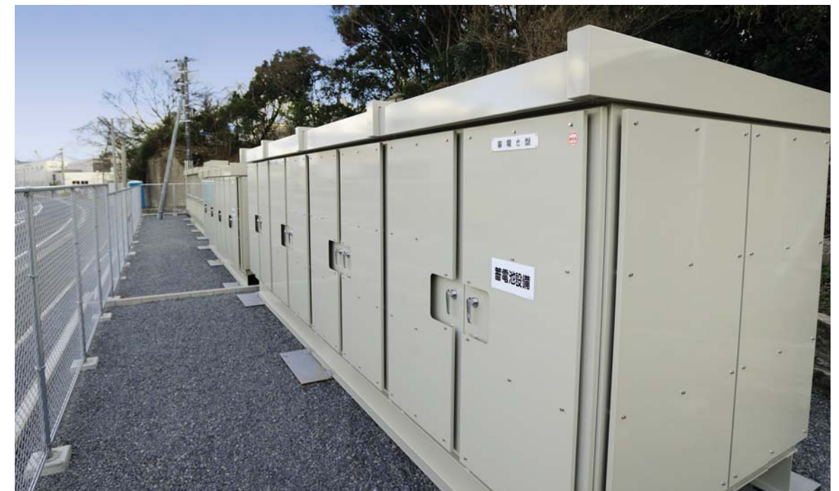
コミュニティ設置型蓄電システム (300kw)
