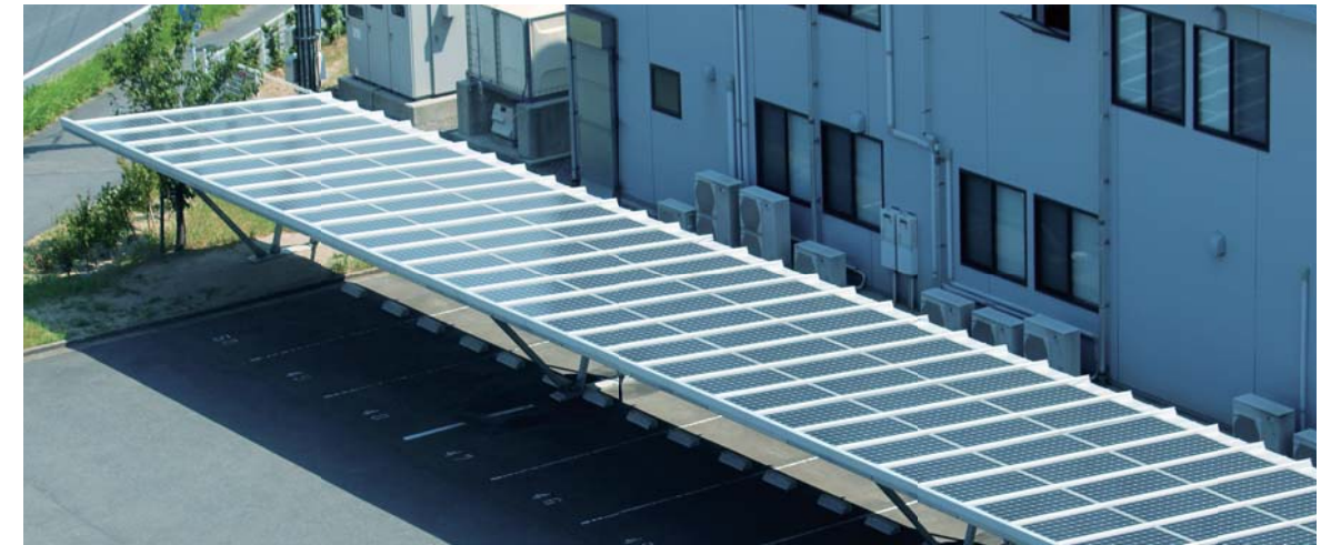
「日鉄住金テックスエンジ」に設置された「キューベン」の太陽光発電
