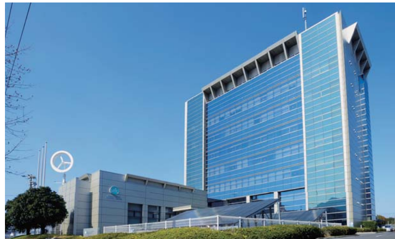
スマートコミュニティセンター（九州ヒューマンメディア創造センター内）
