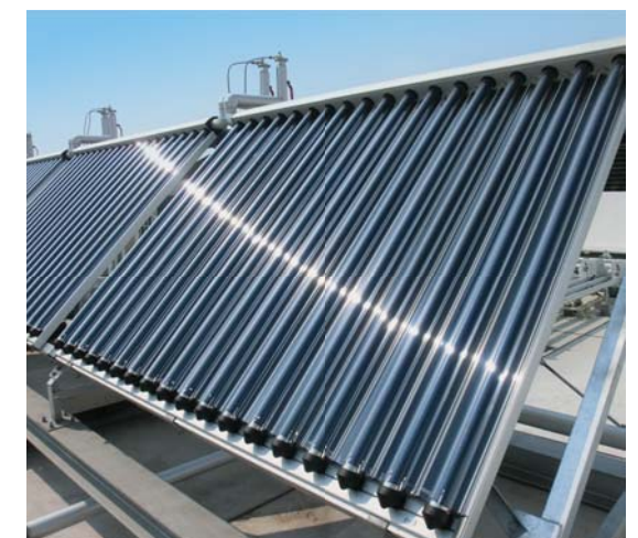
太陽熱利用パネル
