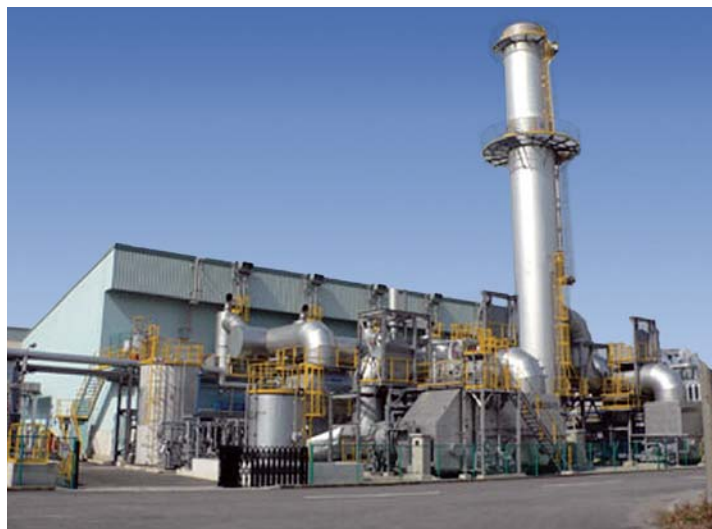
天然ガスを利用した東田地区の基幹電力「東田コジェネ (33,000kw)」
