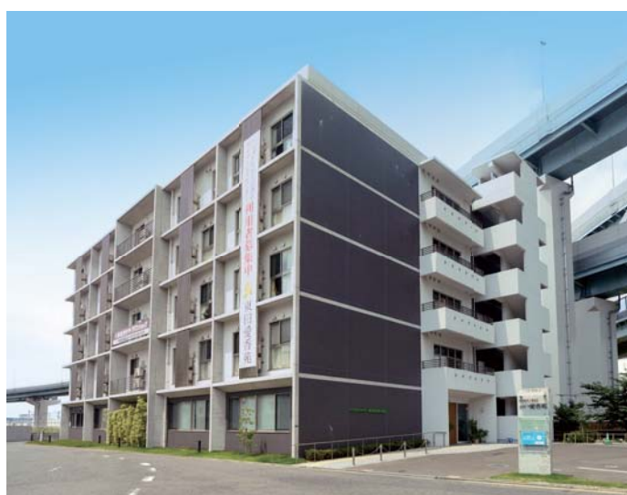
地域の余剰電力を水素に変換して利用する高齢者向け優良賃貸住宅「東田の愛香苑」
