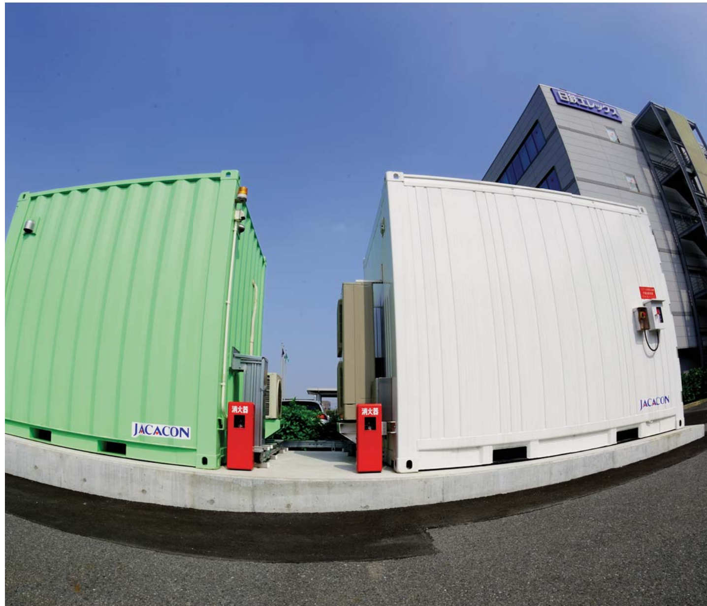
左40kw・右50kw。「日鉄住金テックスエンジ」の大型蓄電池
