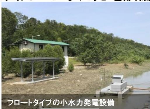
フロートタイプの小水力発電設備
