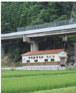
290kWの小水力発電所「めぐみ」
