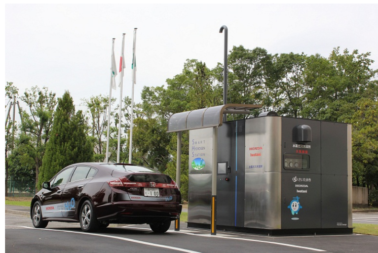
スマート水素ステーションの整備
