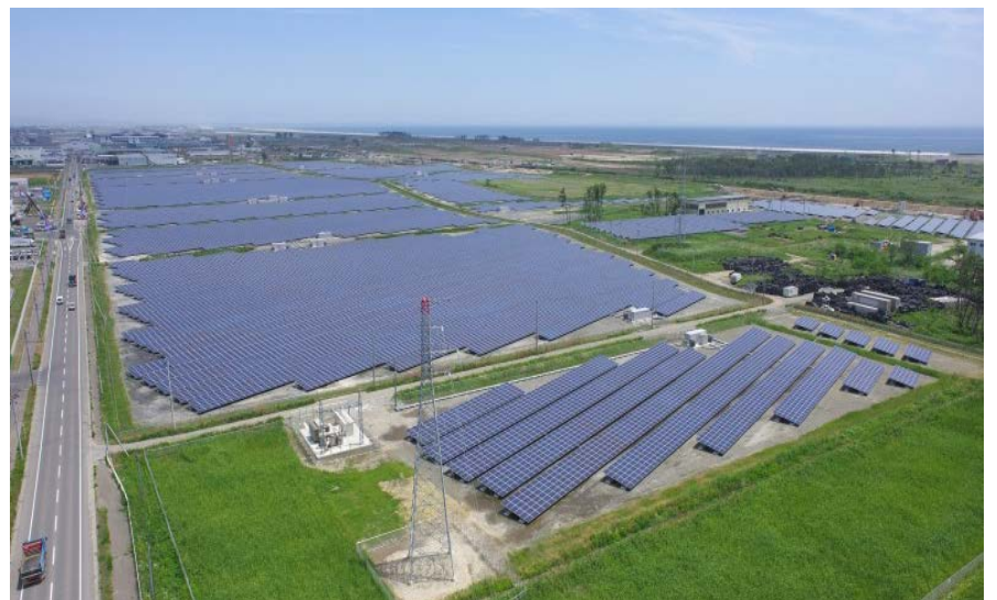
東日本大震災による地盤沈下等で、再生が難しい農地を活用した被災地最大級のメガソーラー
