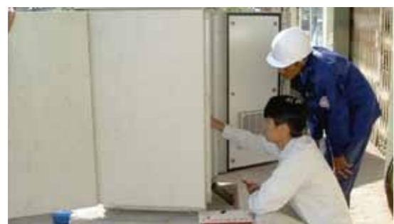
配水ブロックシステムの導入にあたっては、北九州市で実際に使っていた機材をそのままプノンペンに持ち込んだ
