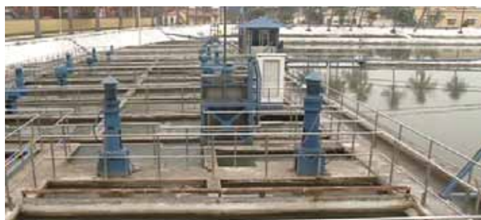
コンパクトにまとまるU-BCFには既存の浄水場を改造することなく設置できるという利点がある
