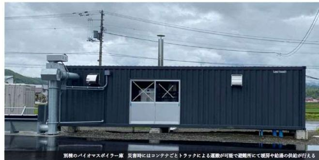
別棟のバイオマスボイラー庫 災害時にはコンテナごとトラックによる運搬が可能で避難所にて暖房や給湯の供給が行える
